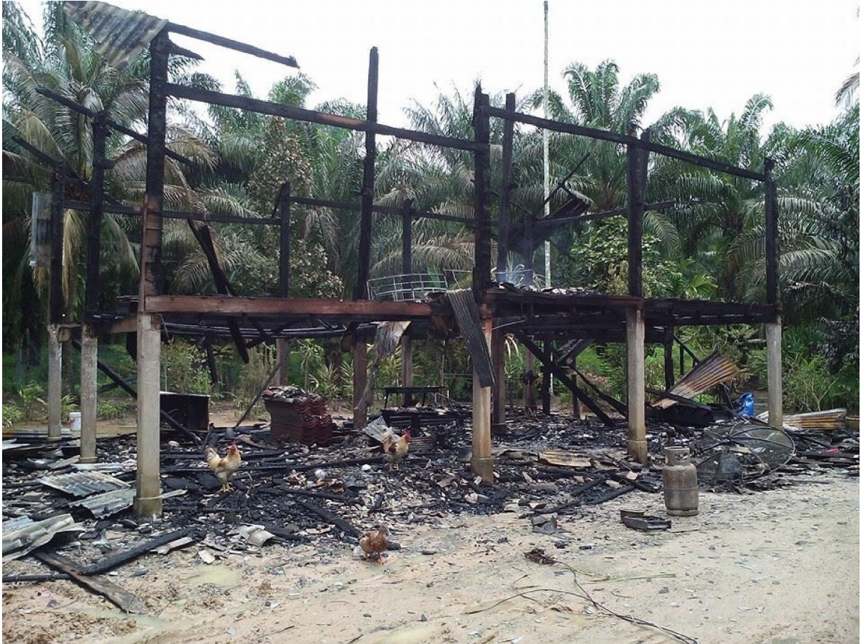
สภาพบ้านที่ได้รับความเสียหาย
